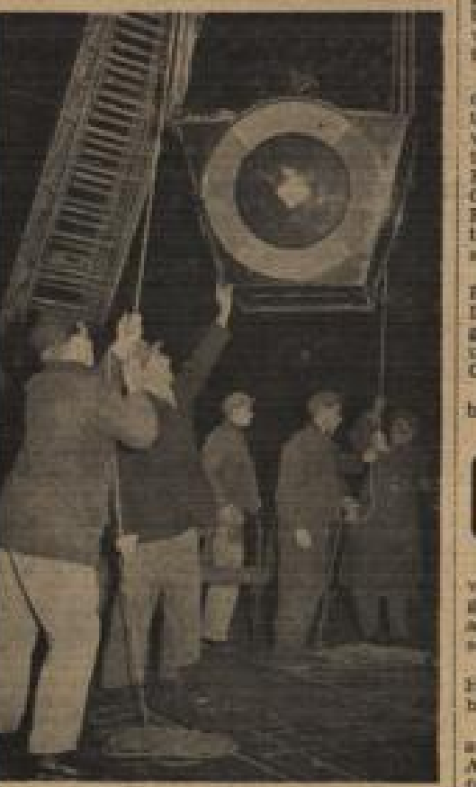
Karlsruhe versucht's mit einer Heuer-Ampel Am Karlsruher Hauptbahnhof ist seit gestern vorläufig eine sogenannte Heuer-Ampel an Stelle eines Verkehrslichtsignals den Verkehr. Unser Bild, das während der Montage in der Nacht von Montag auf Dienstag aufgenommen wurde, zeigt, wie der Regler mit Hilfe von Flutlichtstrahlen über die Kreuzung gehievt wurde. Die Montage, für die der Strom der Straßenbahn ausgeschaltet wurde, verlief ohne Zwischenfälle. Auf Seite 4 wird über die automatische Verkehrsregelung und die neuen Erfahrungen mit der Heuer-Ampel ausführlich berichtet. Foto: Schlotzger
