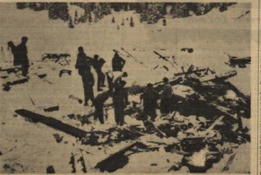
Die Hölle ist verschwunden Unser Bild zeigt die Überreste der durch die Lawine zerstörten Hölle im kleinen Wasserfall arbeitenden Rettungsmannschaften. Wie bekannt fanden dabei 26 Menschen den Tod. Zwanzig Personen, die im unteren Teil der Hölle eingekerkert wurden, kamen mit dem Schrecken davon. In der gestrigen Nummer zeigen wir die Hölle vor dem Unglücksfall.
