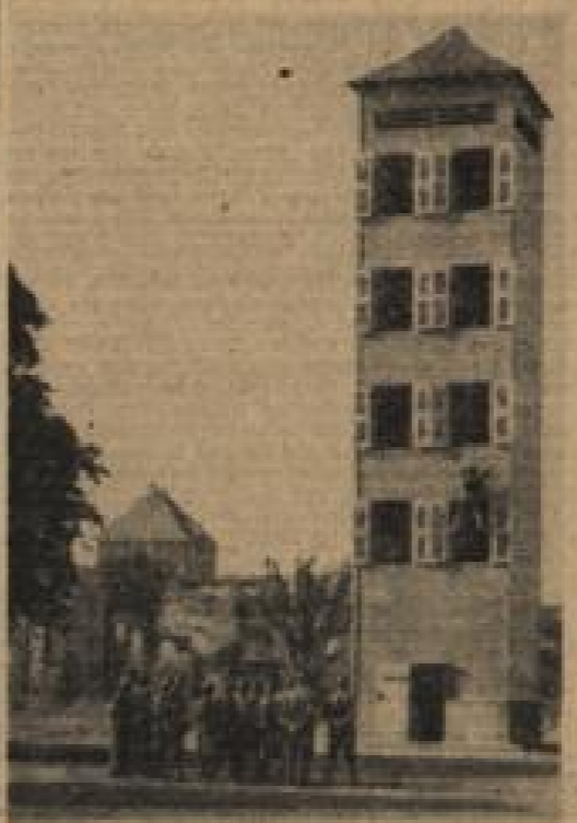
Steger- und Schlauchrockenturm im Gelände der Landesfeuerweherschule Bruchsal.
