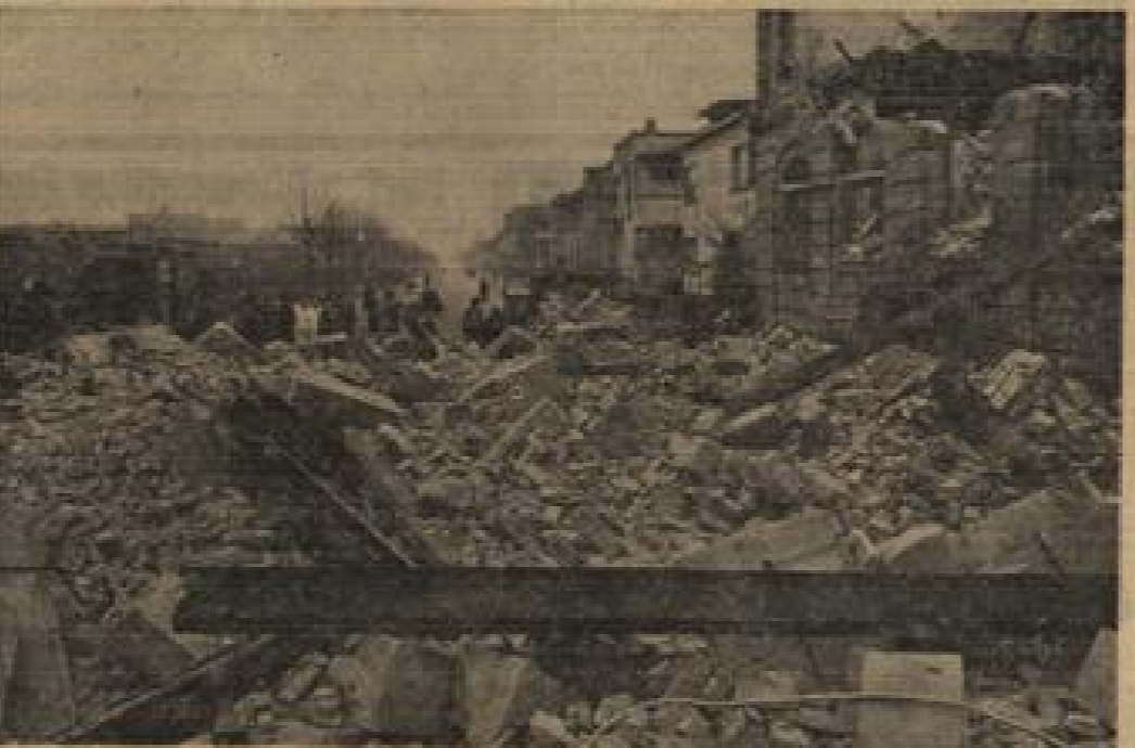
Eine über die ganze Straße sich breitende Masse von großen Hausteinen, Ziegelsteinen und Stahlträgern - das war das Ergebnis des Fassaden-Einsturzes an der Hildapromenade, verursacht durch den unbegreiflichen Leichtsin eines Unternehmers. Foto: G. Schlegel
