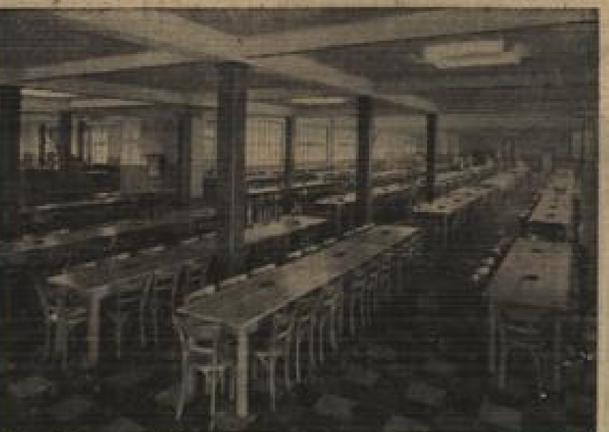
Karlsruher zweitgrößter Saal: Der Speisesaal von Haid & Neu Fabrik; Eckel Bauer
