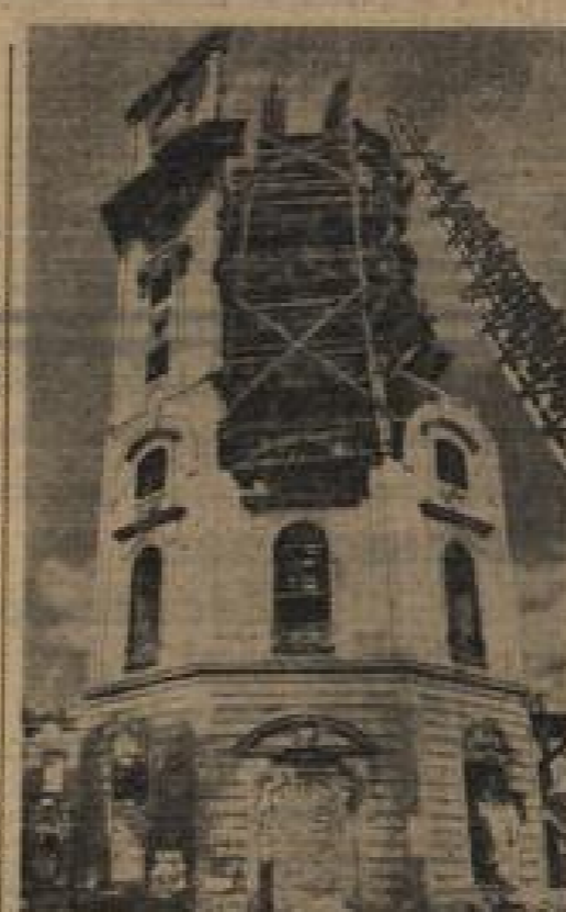
Unser Bild zeigt die Turm-Ruine vom Schloßgarten her gesehen. Im Innern, nach der Stadtseite hin, ist das erhaltene gebliebene Gerüst zu erkennen. Von der großen mittelalterlichen Leier aus untersticht ein Feuerwehmann die einsturzfähigsten Teile des Turms.
