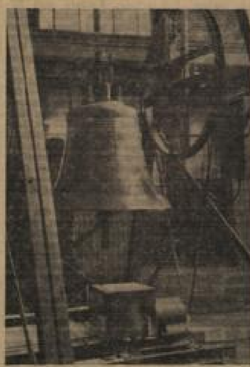
Ein kleiner Elektromotor, der für eine Leistung von 0,5 Kilowatt gebaut ist, genügt hier, um eine 210 kg schwere Glocke anzutreiben.
