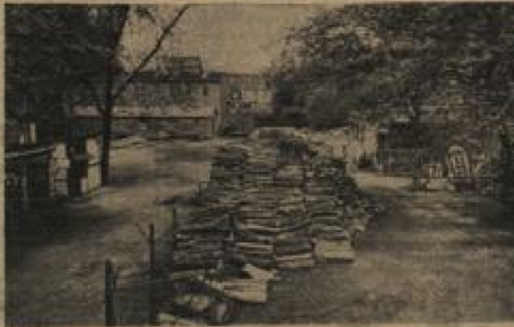
Das war einmal der Sport- und Spielplatz der Uhlenschule. Schüler, Lehrer und Eltern wollten ihn dringend wiederhaben. Aber die Stadt hat dort einen Bauhof, ein Holzauflagerungsplatz und das Auslieferungslager einer Kohlenfirma untergebracht. Foto: Schläpfer
