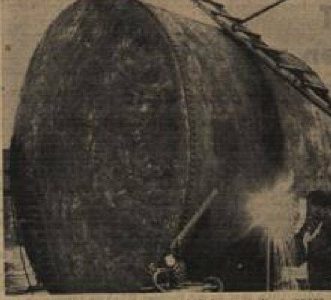
Im Autogen-Schweißverfahren wird der ausgediente 36.000-Liter-Kessel in einen 20.000-Liter-Kessel umgebaut.
