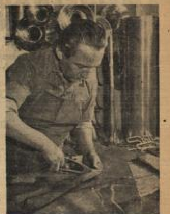
Nach der Schablone wird das Schallstück aus Messingblech zugeschnitten.
