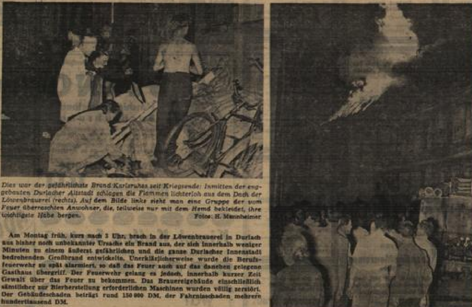
Dies war der gefährlichste Brand Karlsruhes seit Kriegsende: Inmitten der eingestürzten Löwenbrauerei (rechts) schlugen die Flammen lichterloh aus dem Dach der Durlacher Altstadt.
