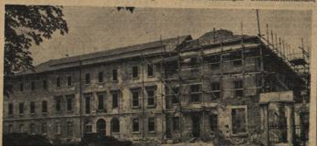
Sitz der Zusatzversorgungsanstalt: Blick auf das Gebäude des ehemaligen Generalkommandos, dessen Wiederaufbau jetzt im Rohbau nahezu beendet ist. Rechts das zum Lisenheimer Tor gehörende, während des Krieges zerstörte Weinbrenner-Wohnhäuschen. Foto: Schöninger
