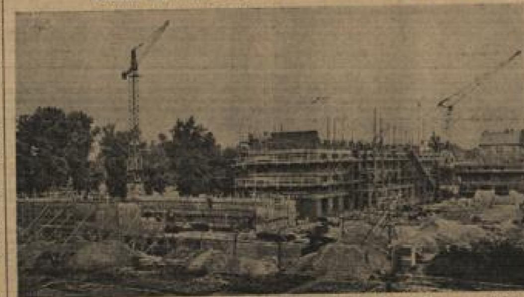
Blick auf die Großbaustelle Arbeitsamt. Im Vordergrund links der Hochbau im Anfangsstadium, in der Mitte das Verwaltungsgebäude, im Hintergrund das Wirtschaftsgebäude.
