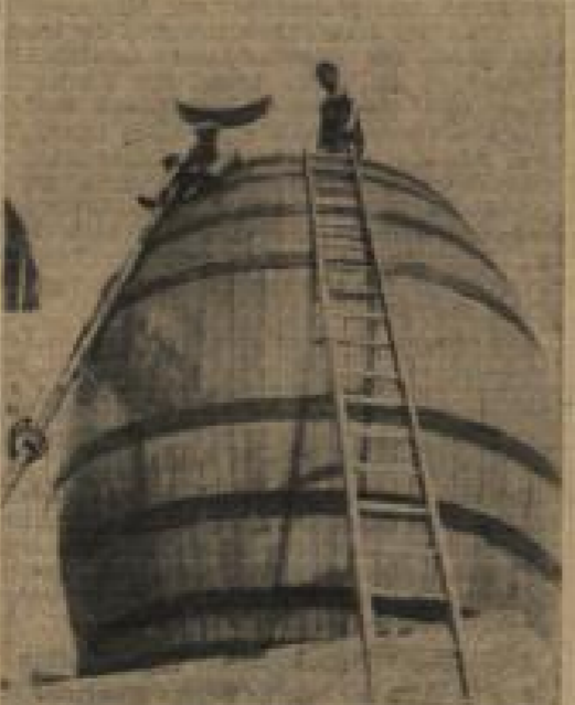
Auf Wahl der Frauennürme wurde der doppelte Inhalt dieses Riesenzuges am Wochenende in München getrunken. Der Riesenzug der Volkspolizei wird zur Beschäftigung der Kupferplatten für die Turmbedeckung verwendet. Unser Bild zeigt die Aufstellung des 40 000-Liter-Fasses auf der Theresienwiese.
