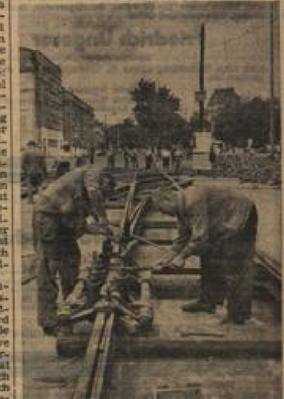
Eine der Baustellen, die zur Zeit zu einer kleinen Umleitung zwingen. In diesem Fall ist es die Straßenbahn, die hier abgefahrenen Schienen durch neue ersetzt...
