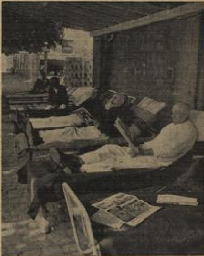
Die Lungenkranken, die täglich eine Liegekur machen müssen, können unter dem Reppdach der Liegehalle bei jeder Witterung die frische Luft genießen.
