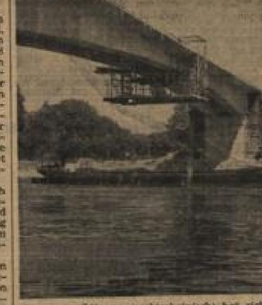
Die erste Öffnung (rechts) hat sich inzwischen geschlossen. Man erkennt deutlich, wie nach einer der beiden Vorbauwagen die Brücke seitlich und von unten umschließt.
