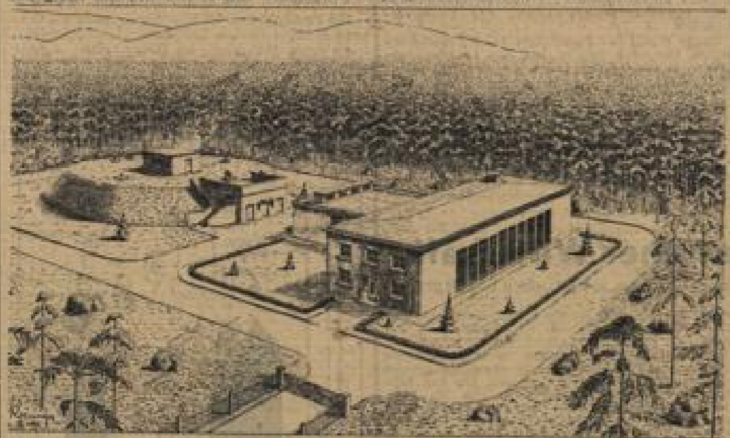
Mitten im Mörscher Wald, etwa oberhalb von der Verbindungsstraße Mörsch-Ettlingen, liegt das neue Karlsruher Wasserwerk, das nun heute ab wesentlich zur Versorgung unserer Stadt mit hygienisch einwandfreiem Trinkwasser beitragen wird.
