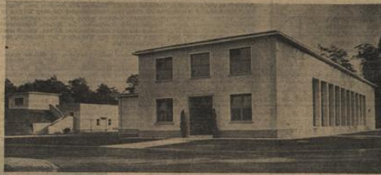
Gesamtsicht der neuen Kraftwerke
