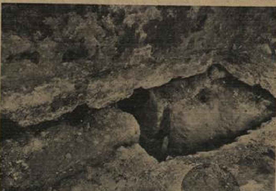
Einer der zahlreichen Gräben unter der Fundamentsohle des Kirchenschiffes ausgehoben wurden. Ganz deutlich sind in die gleichen Abständen befindlichen Hohlräume zu erkennen, die von den Eichengipfeln übergeben sind. Vorn in der Mitte einer der Stämme, die bisher freigelegt wurden — ein deutliches Zeichen, daß die Fundamente dieser Stützen bereits seit Jahrzehnten sozusagen „in der Luft“ schweben.
