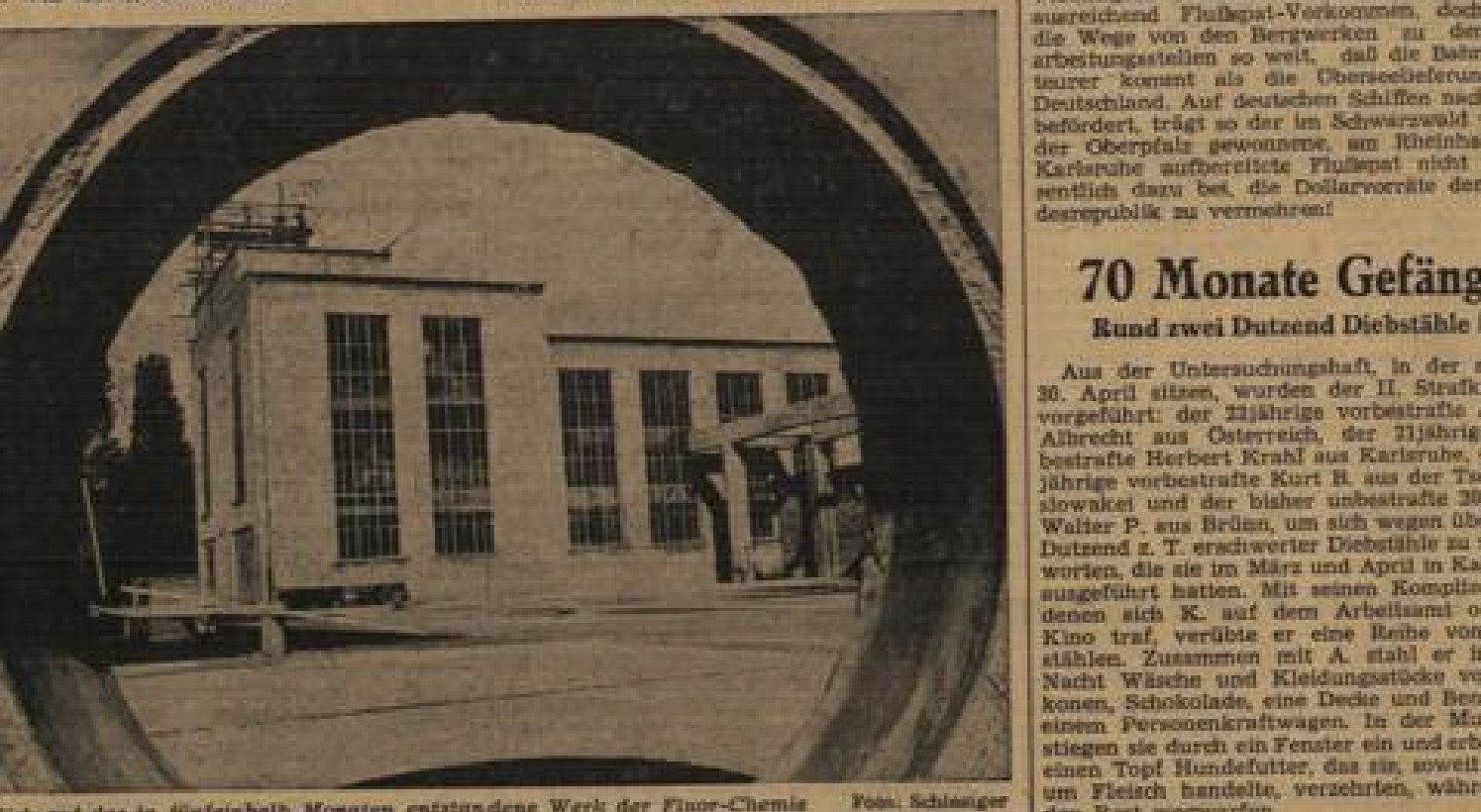
Blick auf das in fünfzehntel Monaten entstandene Werk der Fluor-Chemie
