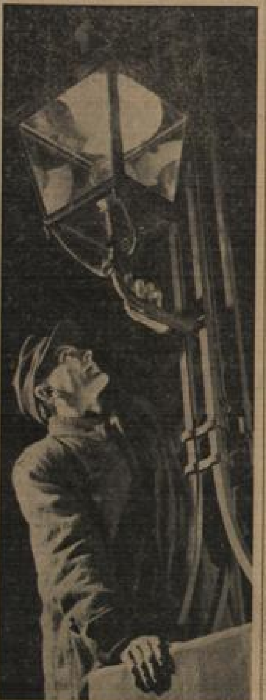
In der Reichstraße am Mühlburger Tor hat Laternenwärter O. Schmidt eine Versager-Lampe entzündet. Ein Zug an der Handklinge, und die gute alte Gaslaterne brennt.
