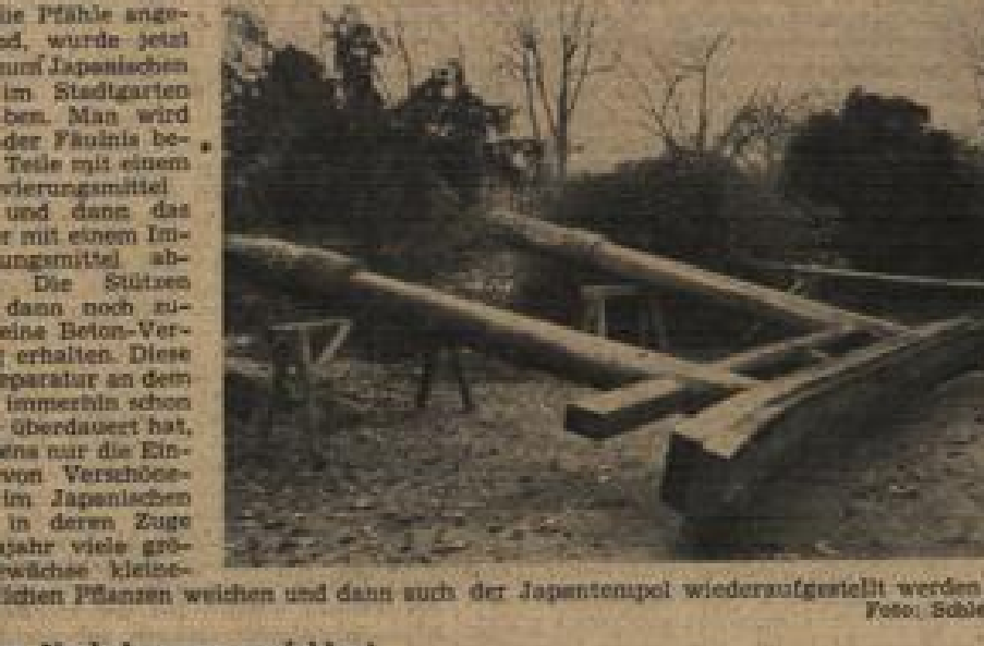
Woll die Pfähle angefaßt sind, wurde jetzt das Tor zum Japanischen Garten im Stadtpark ausgebaut. Man wird die von der Föhnwinde herabfallenden Äste mit einem Kesselfeuerungsmittel impfen und dann das ganze Tor mit einem Impfungsmittel abspritzen. Die Stützen werden dann noch zusätzlich eine Beton-Verstärkung erhalten. Diese kleine Reparatur an dem Tor, das immerhin schon 25 Jahre überdauert hat, ist übrigens nur die Einleitung von Verschönerungen im Japanischen Garten, in deren Zuge im Frühjahr viele größere Gewächse, Klempner, zierlichen Pflanzen weichen und dann auch der Japantempel wieder aufgestellt werden soll. Foto: Schölsger
