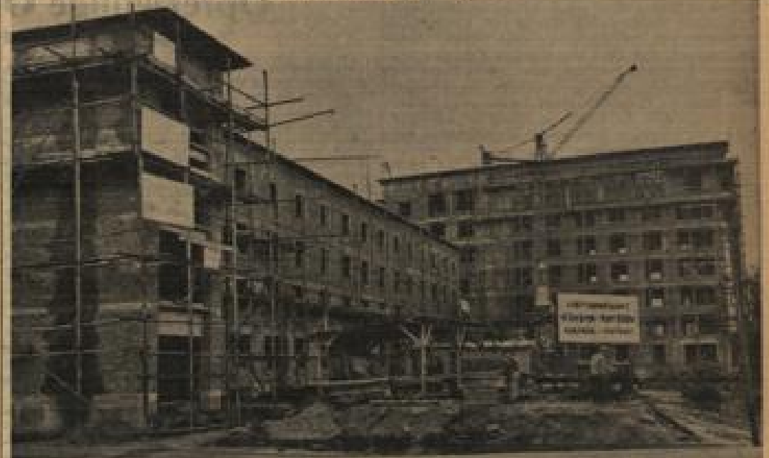
Das neue Arbeitsamt an der Rippurrer Straße im Rohbau.
