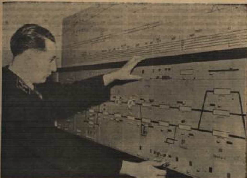
Ein Ausschnitt der Stelltafel mit dem Gleisbild. In den rechteckigen Feldern erscheint als Leuchtschrift die Nummer des Zuges, der den Streckenabschnitt jeweils belegt. Im Bild ganz rechts der Bahnhof Neusmarkt mit dem Ausstellungsplatz. Darüber eine große Nebenbahnstrecke.
