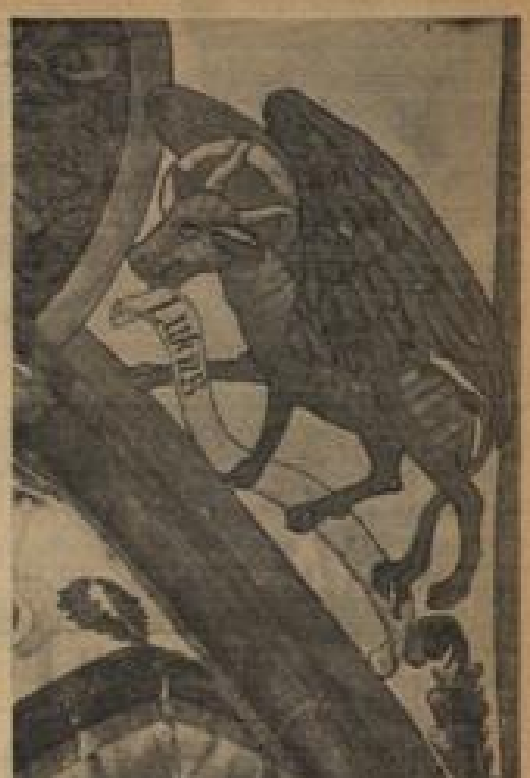
Ein Beispiel für die stümperhafte Restaurierung mittelalterlicher Fresken in Neustadt.
