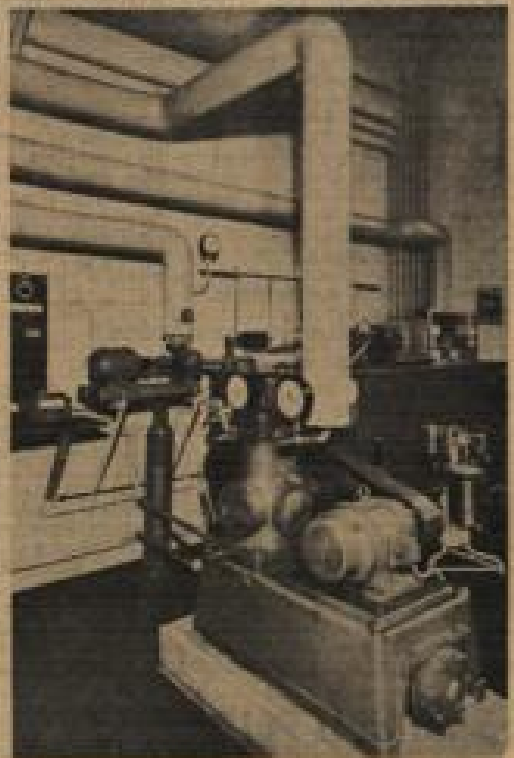
In diesem bildlich ausgestatteten Labor werden die Kältetechniker und Kältemonteurs in die Geheimnisse der modernen Kältetechnik eingeführt.
