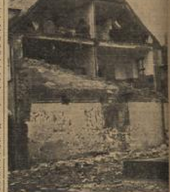
In der Hirschtstraße wurde die Giebelwand eines Wohnhauses eingedrückt. Foto: Schroeder
