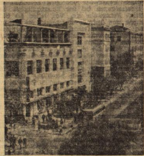
Auch in den Städten des Donezgebietes, wo die faschistischen Horden besonders wüteten, sind ohne fremde Hilfe, ohne Marshallplan und Dollarkredite ganze Stadtviertel mit Wohnhäusern, Schulen, Krankenhäusern, Fabriken und kulturellen Einrichtungen wieder aufgebaut worden. — Blick in einen neu aufgebauten Straßenzug in Stalin o.
