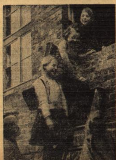
Sie sind neugierig, schon vor der Fertigstellung wollen sie einen Blick in den zukünftigen Klassenraum werfen
