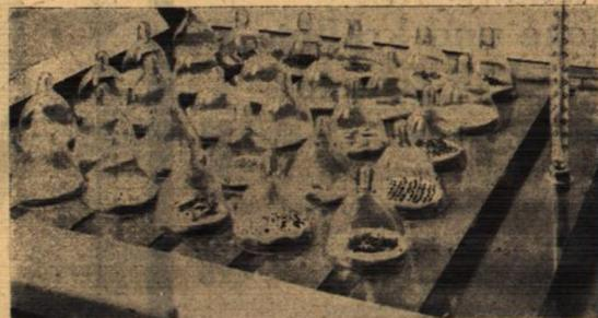
Im Jacobsen-Lichtkeimapparat wird die Keimfähigkeit der „Lichtkeimer“ geprüft
