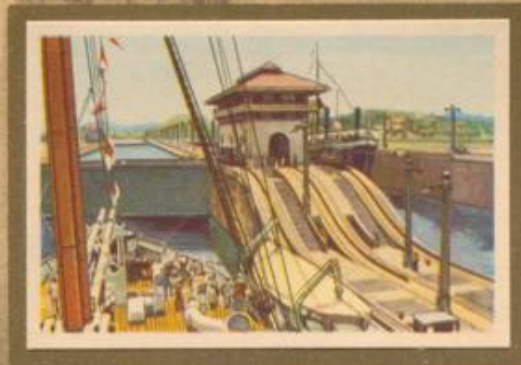
Eine Schleuse des Panamakanals.
