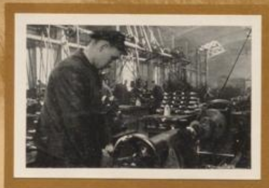
Herstellung von Kurzeisenwellen in einem Eisenwerk
