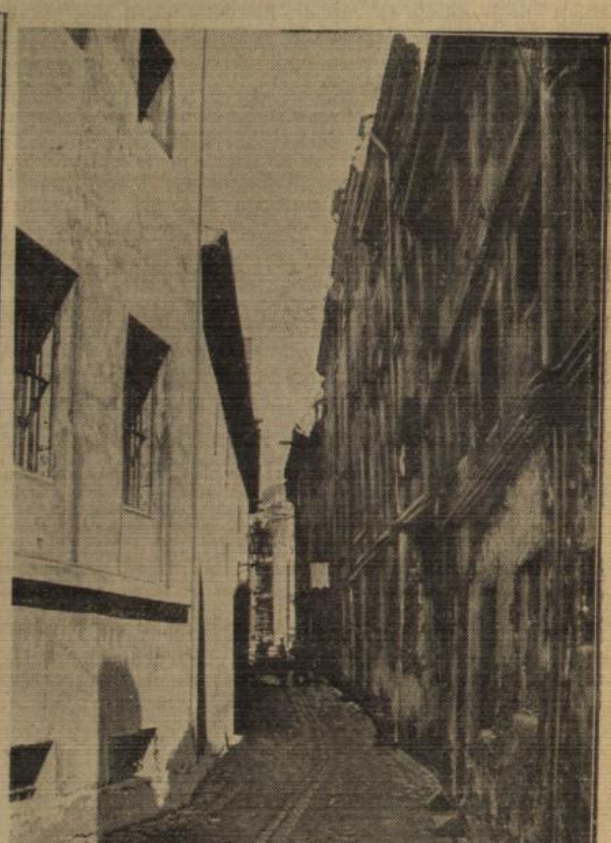
Ein Stück Romantik verschwindet. Einer der ältesten und unhygienischsten Teile von Berlin, der sogenannte Krögel, den unser Bild zeigt, wird in allernächster Zeit abgerissen werden, um Neubauten Platz zu machen.
