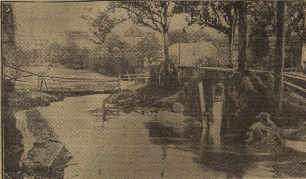
Die Unwetterverwüstungen im Erzgebirge. Eine zwischen Dippoldiswalde und Glashütte von den Fluten zerstörte Brücke. Im Hintergrund eine von der Technischen Reichsanstalt errichtete Notbrücke.
