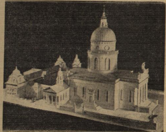
Zu dem Einsturzungsstadium beim Neubau der Kattowitzer Kathedrale.
