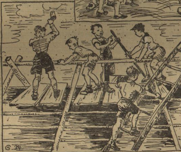
»Die Axt im Haus erspart den Zimmermann.« Das Landjahrheim wird um einen Geräteschuppen bereichert.
