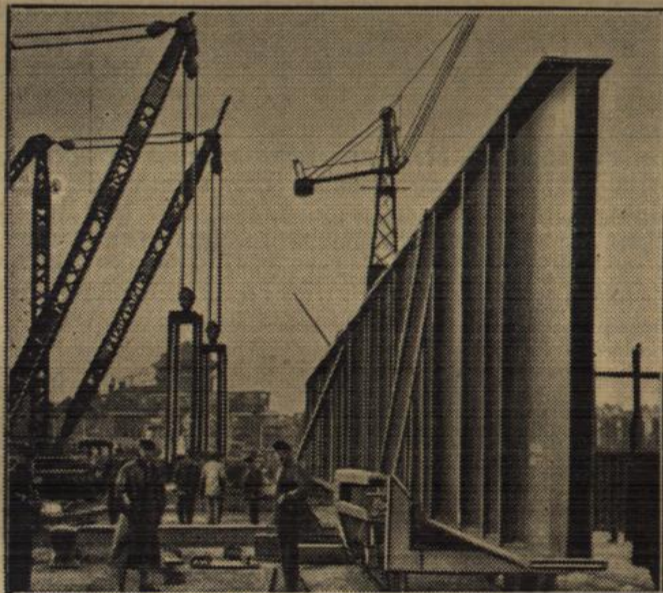
Vom Bau des Rügendammes. Die Arbeiten am Bau des Rügendammes schreiten voran. Hier sehen wir einen der gewaltigen Träger, die auf dem Wasserabschnitt Ziegegraben (Straßfund) nach Dänholm verwendet werden; diese Träger haben eine Länge von 52 Metern.
