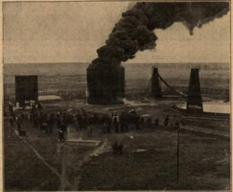
(Abbildung 4) Tank in vollem Brande. Außerordentliche Kühlung durch Wasserberieselung.
