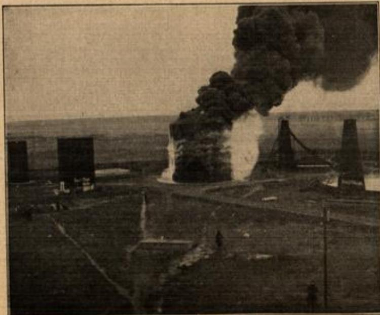
(Abbildung 3) Tank von 10 Meter Durchmesser und 10 Meter Höhe gefüllt mit einem Wasserpolster von 80 cm und Brennstoff von 10 cm Höhe. Beginn des Brandes.
