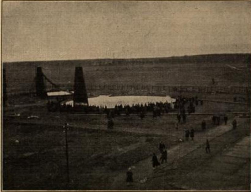
(Abbildung 6) Ablöschen eines Flachtanks von 30 Meter Durchmesser und 1 Meter Höhe gefüllt mit 40 cm Wasserpulver und 2 cm Brennstoff.
