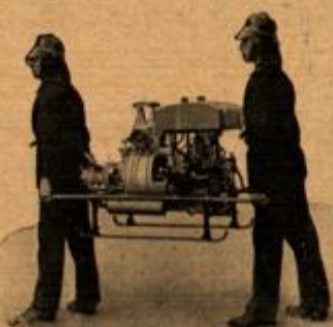
Abb. 3 Zwei Feuerwehrleute tragen die Magirus-Kleinmotor-spritze „Liliput“. Für kleinere Gemeinden und Fabriken ist es der zweckmäßigste Feuerschutz. (2 Größen, 400 und 600 Min.-Ltr.)
