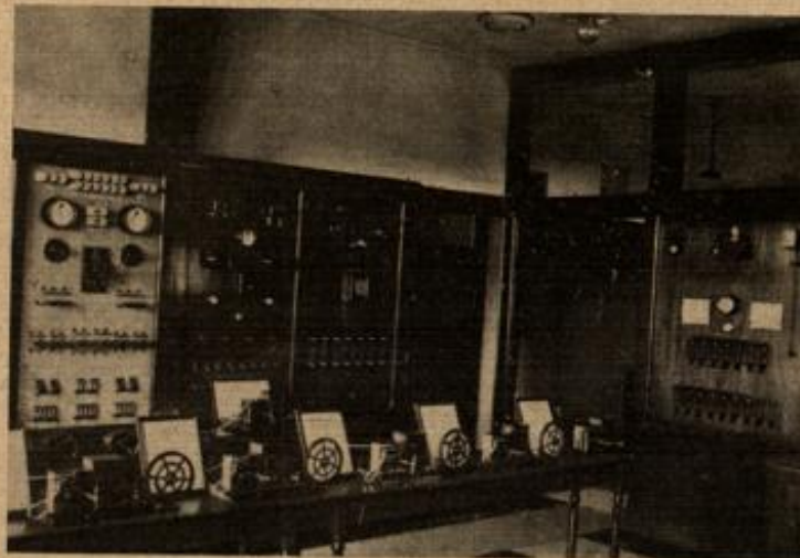
Telegraphenzentrale der Hauptfeuerwache, Einladungs-Morsesystem
