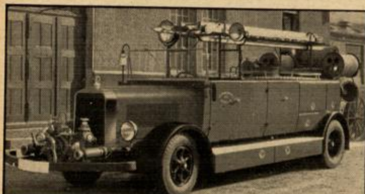
Eine der an die Feuerwehr Dresden gelieferten 6 Mercedes-Benz-Metz-Kraftfahrerdrehleitern, 30 plus 2 m Steighöhe.
