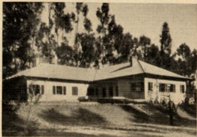
Deutsche Gesandtschaft in Addis Abeba. Basalt-Massivbau mit Eternitdach.
