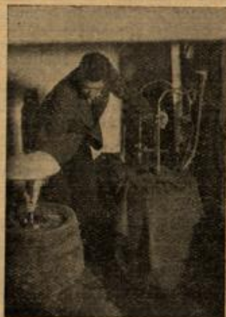
Bild 2. Eine Stehlampe aus Metall gehört nicht in den Keller, weil ein Körperschluß in der Lampe einen gefährlichen Stromdurchgang durch den menschlichen Körper hervorruft.
