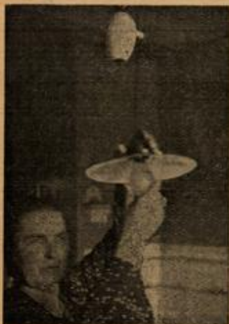
Bild 1. Zuggendellampen mit Lampenfassungen aus Metall sind in Küchen und ähnlichen Räumen mit leitenden Fußböden unfallgefährlich.
