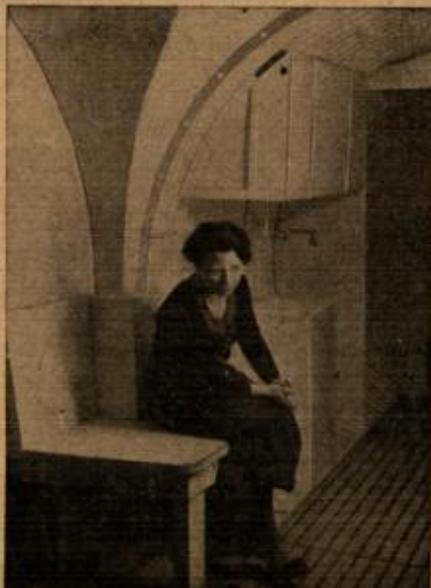
Abb. 2: Der Stollenrundung angepasste Wasserbehälter und Waschtische für Schutzräume
