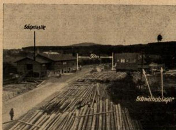
Abb. 5 Feuerchutztechnisch zweckmäßiger Sägewerksbetrieb (Fa. Kast, Hörden)
