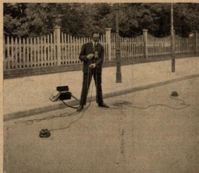
(Werkbild) Scheinlampenbatterie, wodurch eine ausreichende Betriebsbereitschaft des Abhörgeräts gewährleistet wird.
