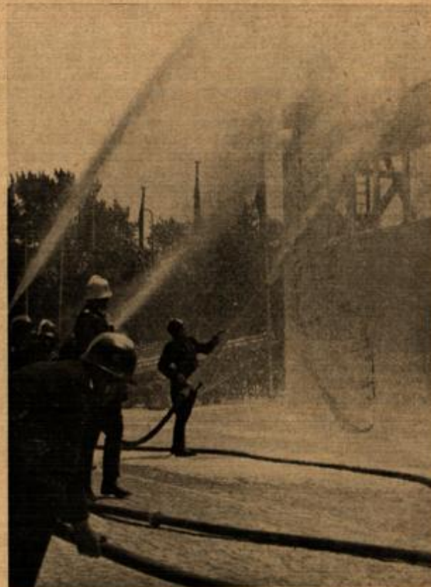
Komet-Schaumlöschangriff auf das Steigergerüst
