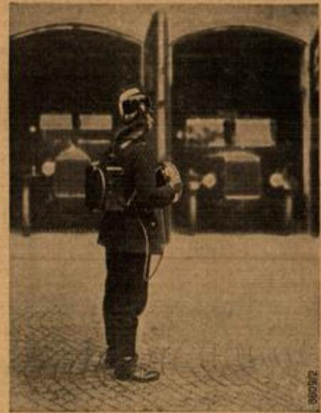
Abb. 3: Ein Mann trägt und bedient Scheinwerfer und Batterie.
