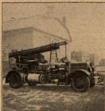
ORIGINAL SCHOENE AERO-Schaumpumpe Typ 220 an automobilem Löschzug
