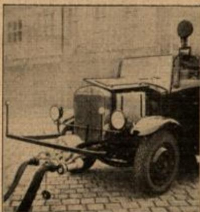
ORIGINAL SCHOENE AERO-Schaumpumpe an Großbrand-Löschzug
