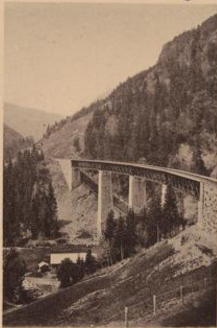
Viaduct üb. d. Ravennaschlucht.
