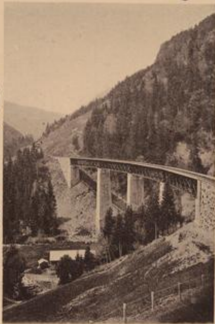
Viaduct üb. d. Ravennaschlucht.
